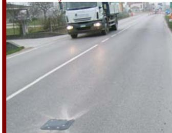
Rilevi flussi veicolari con contatori automatici
